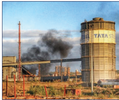
Tata Steel Ltd. Kalinganagar, Odisha AeroSound® ESA
